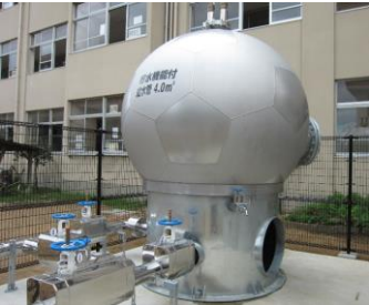
貯水機能付き配水管 6 t (市役所本庁舎に設置)
