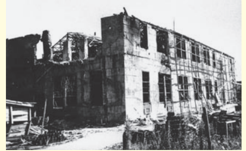
艦砲射撃で破壊された多賀工場
