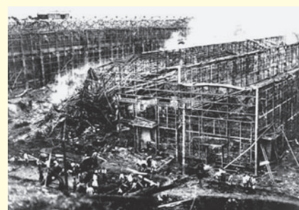
1トン爆弾で破壊された日立製作所海岸工場
