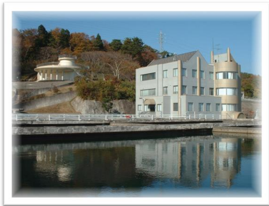
森山浄水場 管理事務所
