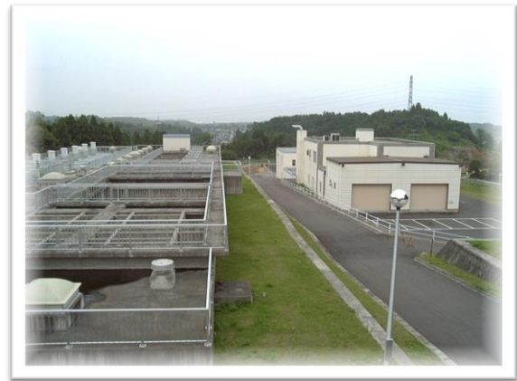
十王浄水場 全景
