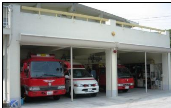
日立消防署西部機関員派出所
