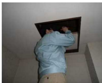
「小屋組・梁」調査の様子
