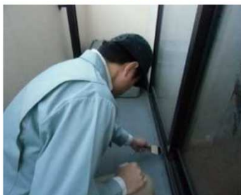
「外部（バルコニー）」調査の様子
