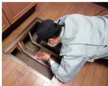
「土台・床組、基礎」調査の様子
