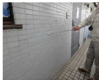
「外部（外壁）」調査の様子
