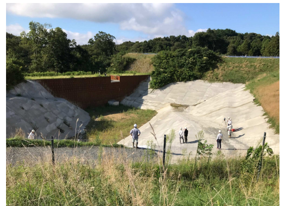
土砂等流出を防ぐ太陽光発電所の調整池
