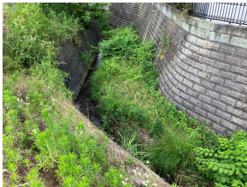
しゅんせつ 【浚渫前】
