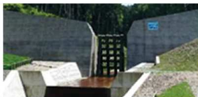
砂防堰堤工
