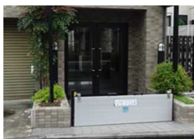
①防水板設置
