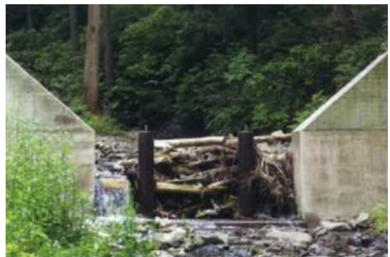
流木対策用の治山ダム（大子町頃藤地内）
