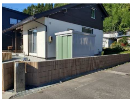
③浸水防止塀設置
