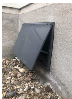
②浸水防止蓋設置
