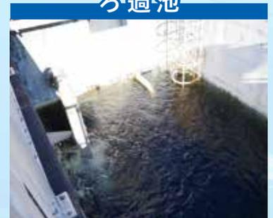
沈殿池で取りきれなかった小さな汚れを、砂の層でろ過して取り除きます。
