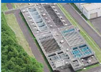
水の汚れを集める薬品(凝集剤)を加え、汚れを大きなかたまりにして、池の底に沈めます。
