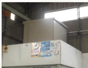
受変電設備更新
