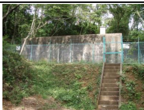
神峰ポンプ場
