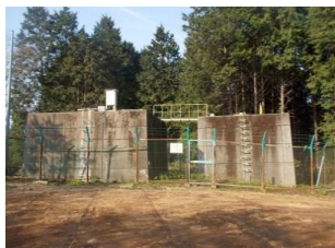
中 井 山 ポ ン プ 場 (森山町3丁目)
