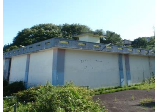
○ 台原配水池向ポンプ設備
