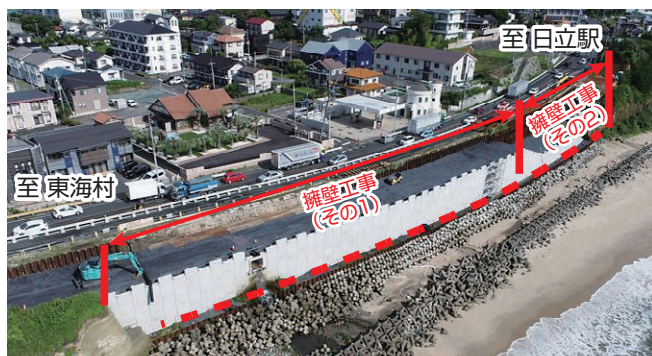
一般国道245号日立港区北拡幅の俯瞰写真
