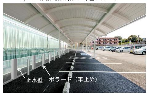
図25 庁舎西側外周部の止水壁のイメージ
