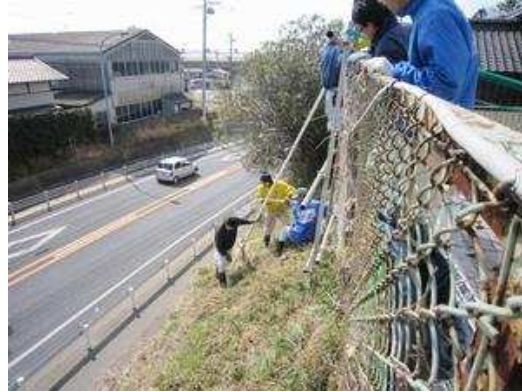
(壁の補強作業)
