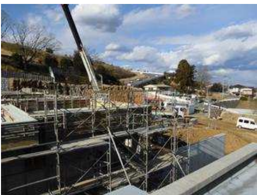
《工事現場の様子》
