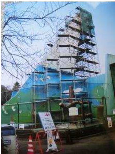
<工事中のシンボルタワー>
