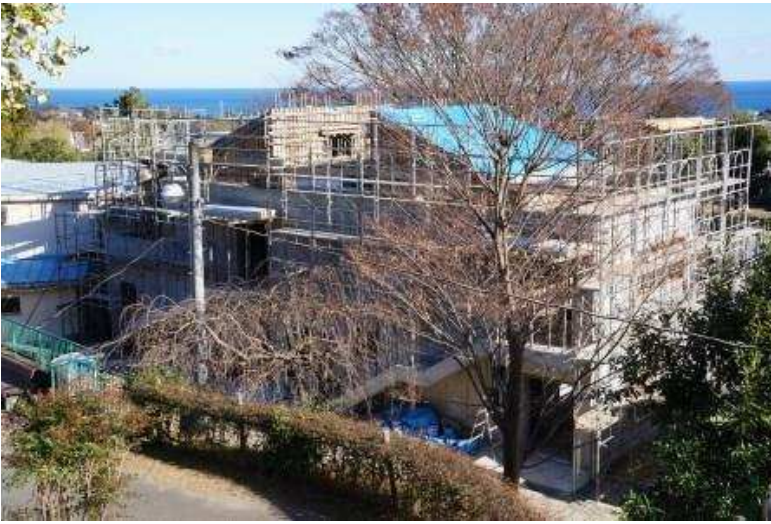
屋根部分の作業風景です。
