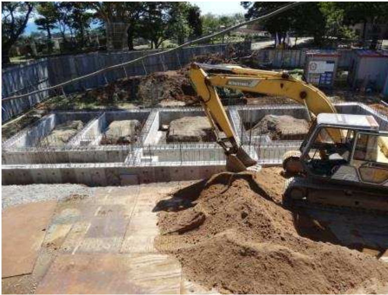
基礎の周りを埋めていきます。
