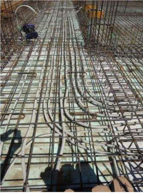
いろいろな配管が鉄筋の間を通っています。
