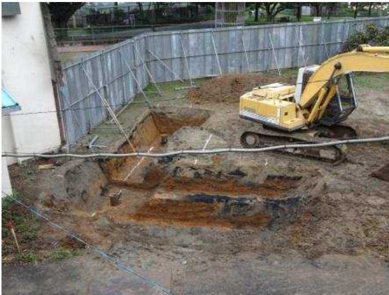
先週打設した杭が見えてきました。
