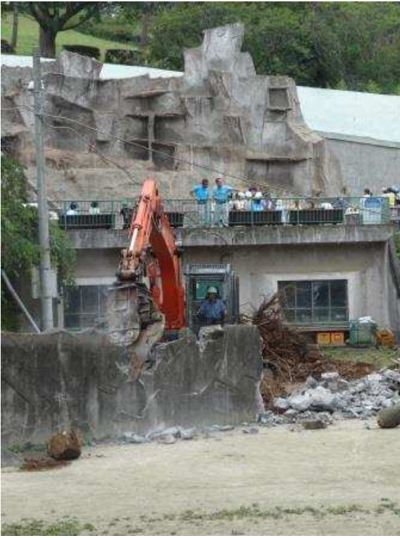
大きなはさみで切断？。重機パワー恐るべし。
