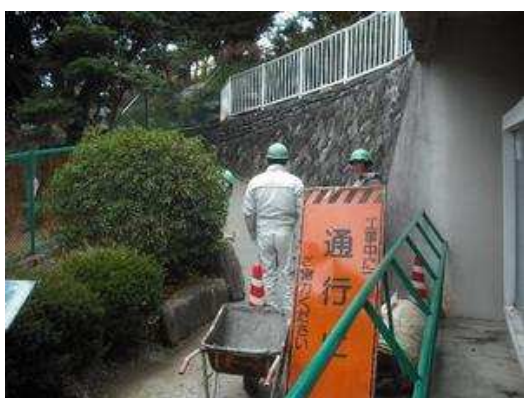
ライオン舎脇の園路を滑らかスロープに改良中。
