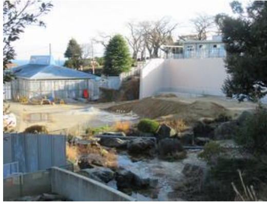
《新二ホンザル舎が建設中》
