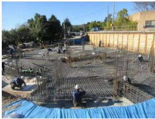
《建設中「はちゅうるい館」の現在》
