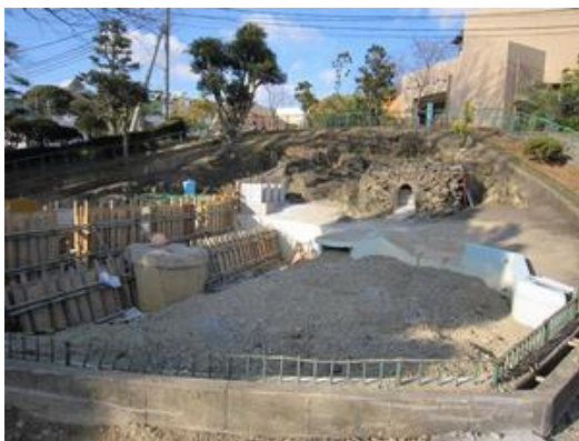
新しいペンギンの施設も工事中
