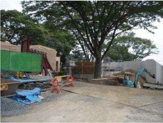
急ピッチで進む工事
