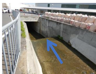
現状の落差工
