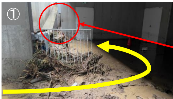
地下1階 駐車場
