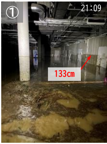
地下1階 駐車場
