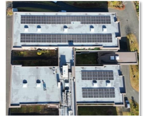
屋上設置の太陽光
