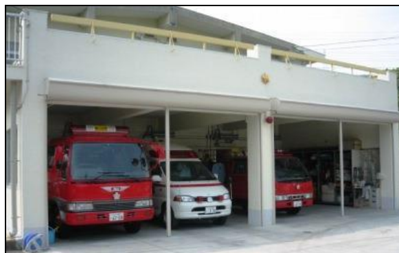
日立消防署西部機関員派出所
