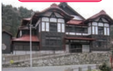
日立武道館(旧共楽館)
