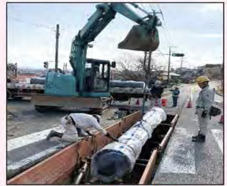
水道管の取替工事の様子
