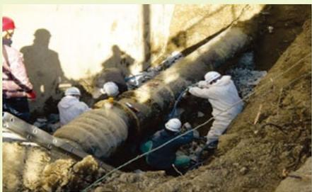
滑川中継ポンプ場圧送管破断修理
