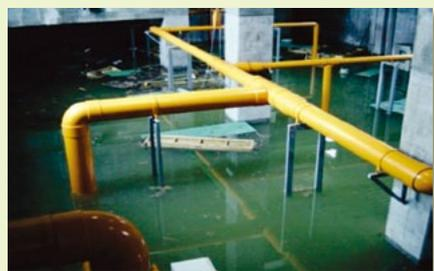
河原子中継ポンプ場電気室浸水
