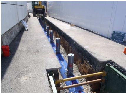
下水道管の設置状況(工事施工中の状態)
