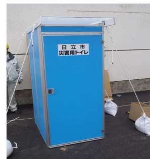
マンホールトイレの外観
