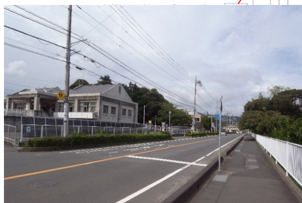
通りを挟んで立地する油縄子コミュニティセンター
