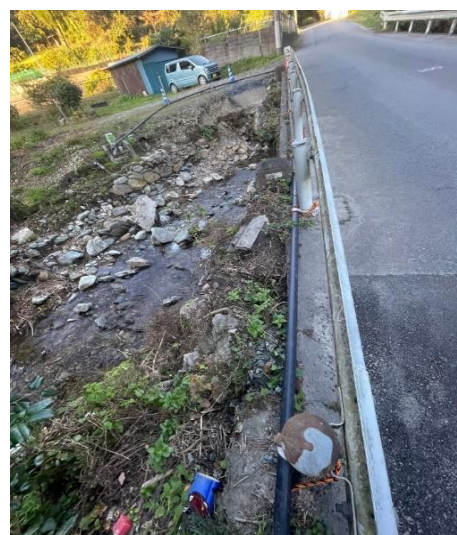
仮配管により通水し、断水は解消している。
