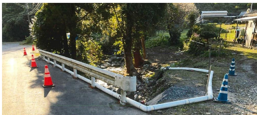
現在の状況（仮配管に保温材を設置して凍結防止を図っている。）
