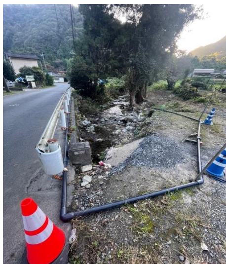
仮配管により通水し、断水は解消している。
