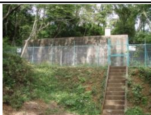
神峰ポンプ場
