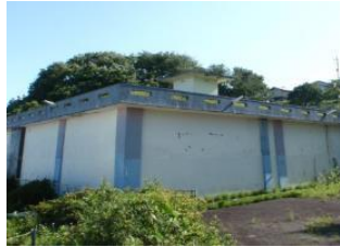
○ 台原配水池向ポンプ設備
