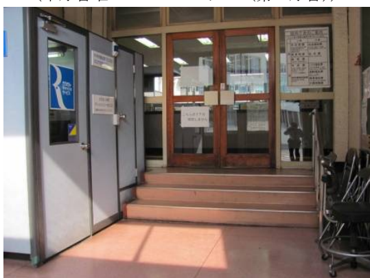
(段差の状況① (第3庁舎入口))
