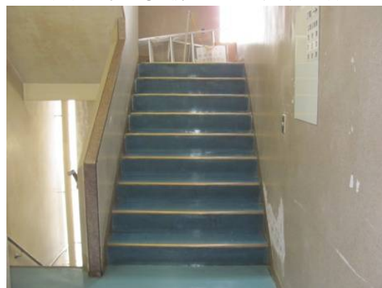
(手すりのない階段 (第2庁舎))
