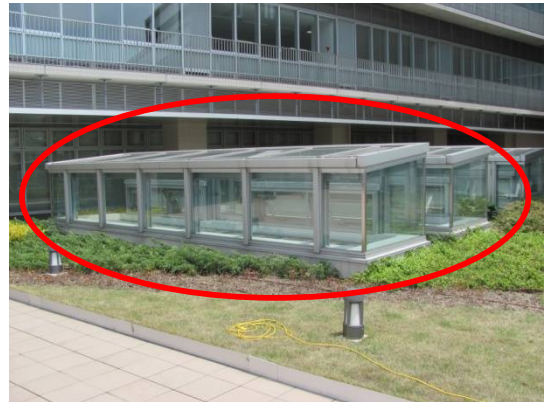
(自然換気・採光のための換気塔② (青梅市))
