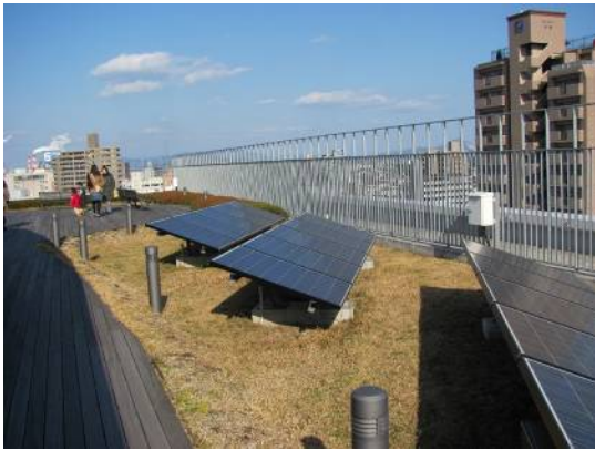
(太陽光発電パネルの設置 (岩国市))
