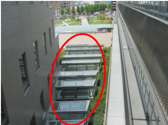
(自然換気・採光のための換気塔① (青梅市))
