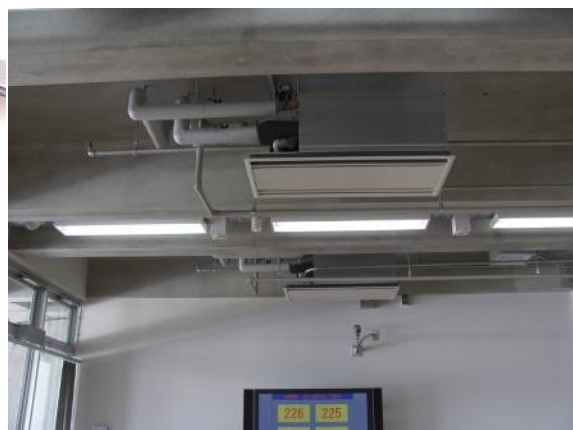
構造躯体と設備が分離された スケルトン・インフィルの事例（立川市）
