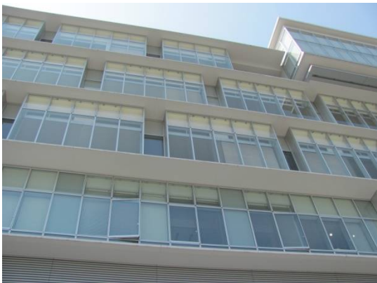
(冷房負荷を低減する庇のついた窓 (岩国市))
