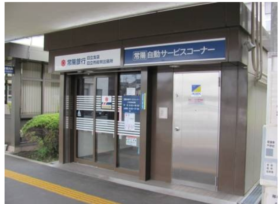
(庁舎外 (案内所脇) に設置されたATM)
