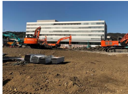
国道6号から見る新庁舎
