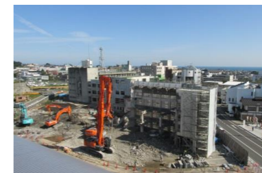
旧庁舎の解体 (10月)
