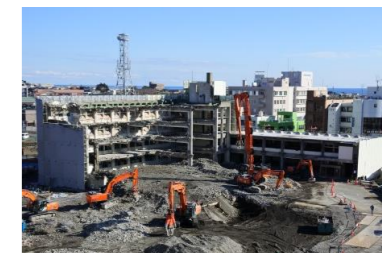
旧庁舎の解体 (12月)
