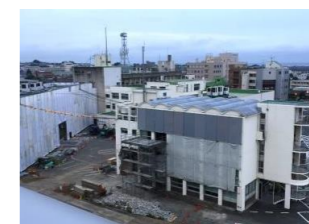
旧庁舎の解体
