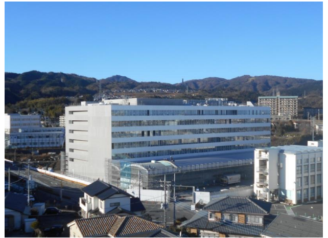
■全体工事風景 南側から工事現場を見ています。
