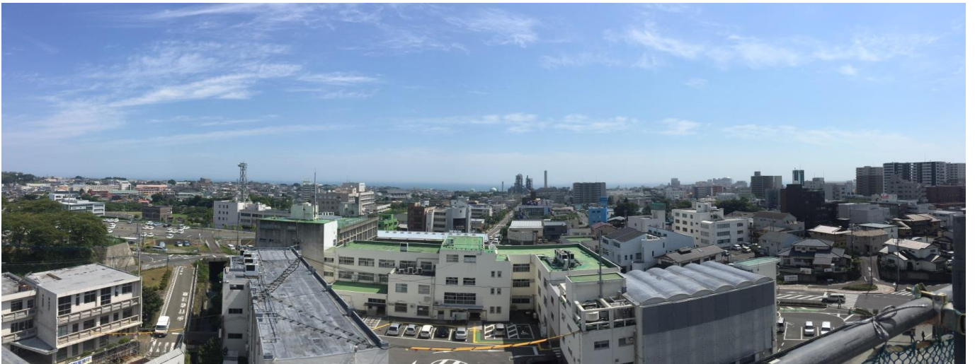
■屋上からの風景 床のコンクリート打設が完了した屋上から現庁舎を見えています。7階建の新庁舎の高さを実感することができます。
