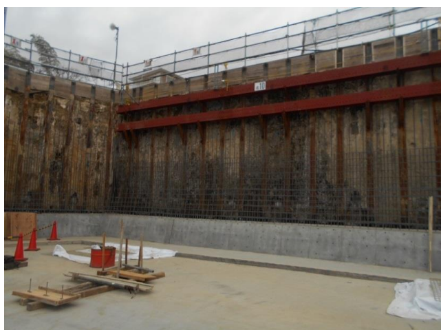
■地下の擁壁工事 高さ7mの鉄筋コンクリート造の土留め擁壁を作っています。鉄筋を組み立て、下の方から段階的にコンクリートを打設します。
