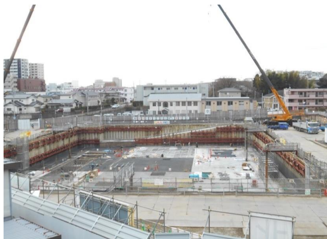
■全体工事風景 北側から工事現場を見ています。
