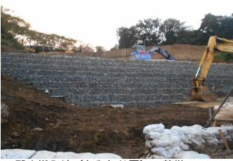
■残土搬入地(かみね公園)の整備 工事に伴い発生する残土の一部は、かみね公園 駐車場整備に使用することとしています。 整備に当たり盛土した土砂が流出しないように 石段を積上げています。
