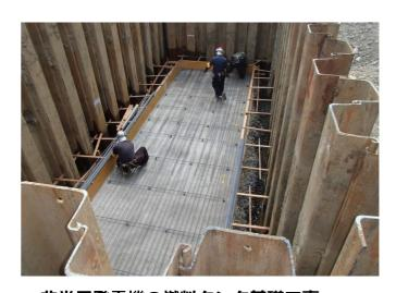
■ 非常用発電機の燃料タンク基礎工事 災害時の拠点となる新庁舎には、非常用発電機を 設けます。 現在、燃料タンク基礎の鉄筋を組んでいます。
