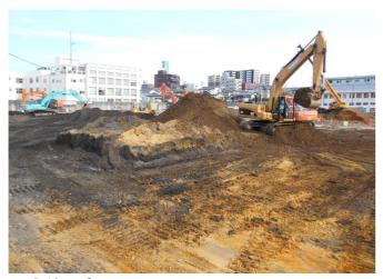
■全体工事風景 その2 基礎の掘削工事に向けて整地をしています。
