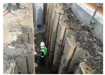
■公共下水道の本管設置工事 新庁舎の敷地内を通る下水道の本管を新たに埋設 しています。(写真奥はマンホール)
