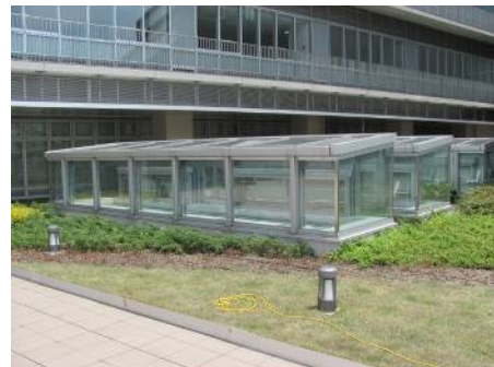
自然換気・採光のための換気塔（青梅市）
