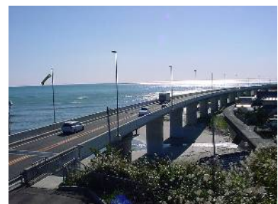
国道 6 号日立バイパス
