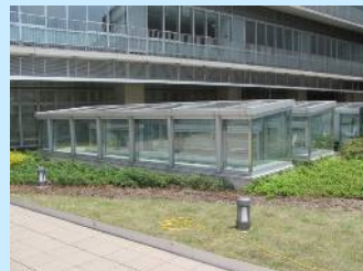
自然換気・採光のための換気塔（青森市）
