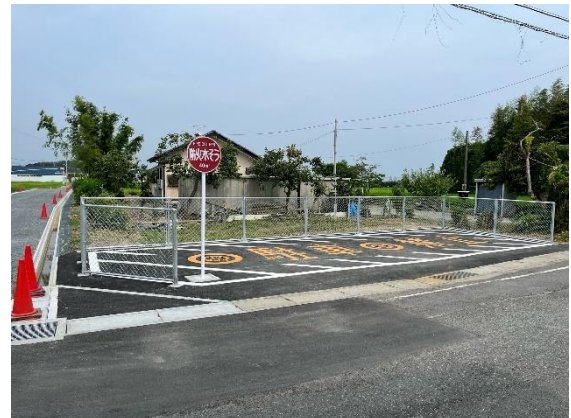
防火水槽の周辺に駐車禁止区域を明示
