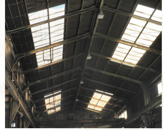
事務所・工場内全照明のLED化を実践
