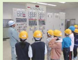
【川治第一発電所見学】
