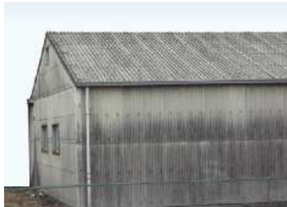
【石綿含有スレート波板（屋根・外壁）】
