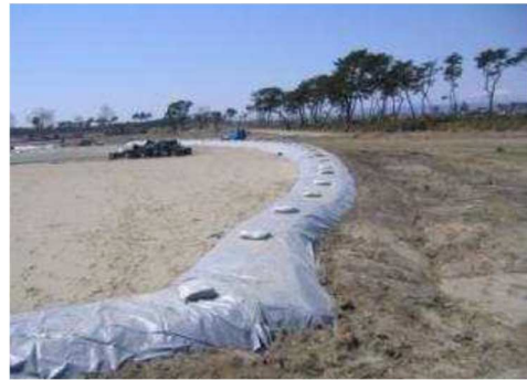
遮水シートを敷設した仮置場の事例 出典：仙台市HP
