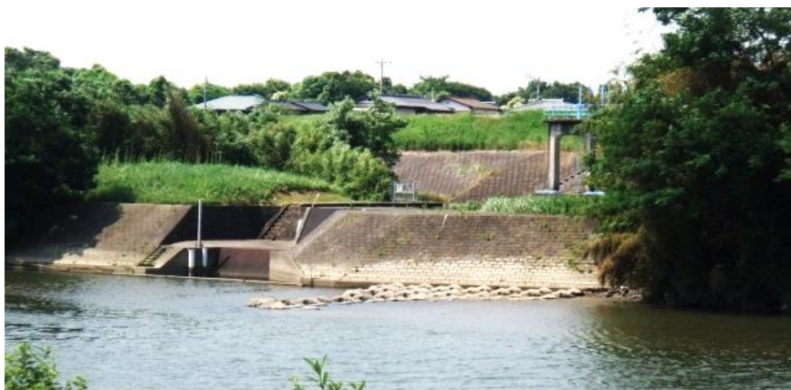
久慈川取水口（森山浄水場）
