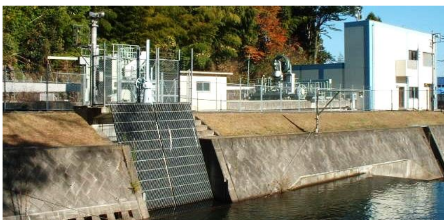
十王川取水口（十王浄水場）
